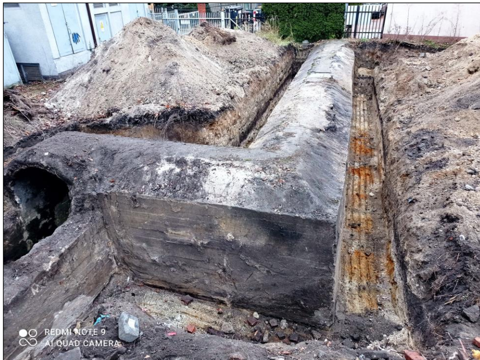
Ryc. 4. Poznań, ul. Kolejowa 50/52. Konstrukcja schronu po odsłonięciu. Po lewej stronie widoczny fragment częściowo zniszczonego zejścia od strony wschodniej do wnętrza szczeliny, następnie przedsionek wraz z pomieszczeniem sanitarnym, zaś po stronie prawej zdjęcia właściwe pomieszczenie służące ochronie ludności podczas bombardowania – ujęcie od E (fot. P. Banaszak).
