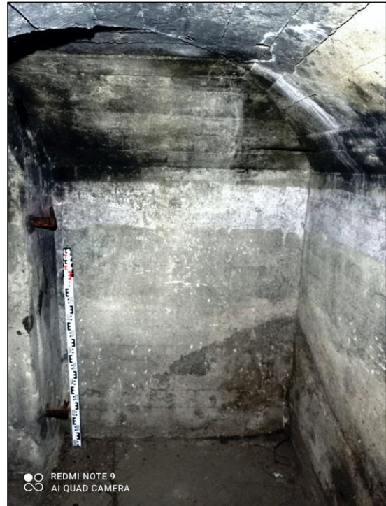
Ryc. 7. Poznań, ul. Kolejowa 50/52. Namalowane na ścianach przedsionka białe pasy mające na celu ułatwienie orientacji przebywającym w schronie osobom — ujęcie od S (fot. P. Banaszak).
