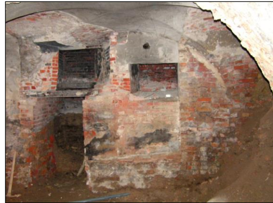
Ryc. 3. Kościół oo. franciszkanów w Poznaniu. Prace budowlane w kryptach – murowana ściana ossuarium nr 1 (fot. J. Wrzesiński)
