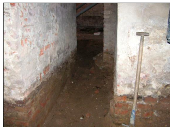
Ryc. 4. Kościół oo. franciszkanów w Poznaniu. Prace budowlane w kryptach: odsłanianie filarów (fot. J. Wrzesiński)
